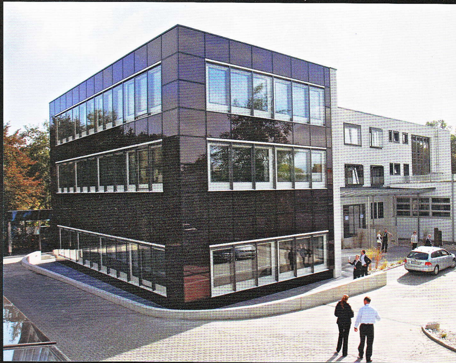
3. kép – Energia nyerő homlokzat az IFT új irodaépületén /Forrás: www.ift-rosenheim.de pressefotos/
