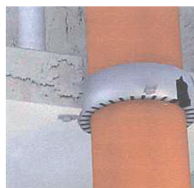
Csőmandzsetta műanyag csővezetékben
