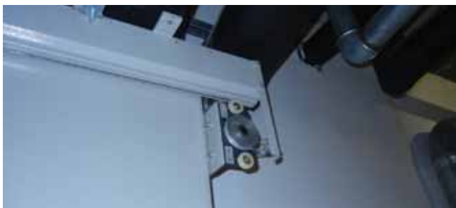
NYITVA TARTÁST BIZTOSÍTÓ, ÉS CSUKÓDÁSI SEBESSÉGET IS SZABÁLYOZÓ ESZKÖZ
