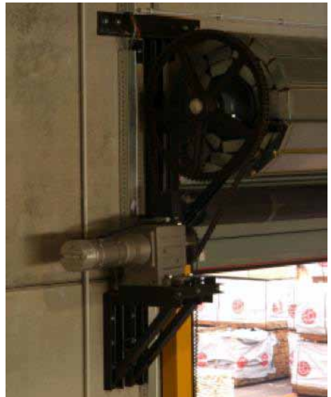
TŰZGÁTLÓ REDŐNYKAPU TARTÓSZERKEZETE
