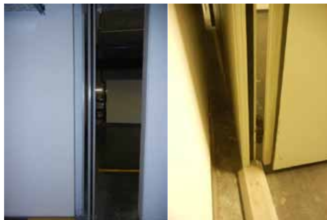
HŐRE HABOSODÓ TÖMÍTŐSZALAGOK A KAPU SZÁRNYÁNAK ÉS A KAPU TOKSZERKEZETÉNEK TALÁLKOZÁSÁNÁL (BALRA), AZ ÁTJÁRÓ AJTÓSZERKEZET ÉS A TOLÓKAPU SZÁRNYSZERKEZETE KÖZÖTTI HÉZAGOK MENTÉN (JOBBRA)
