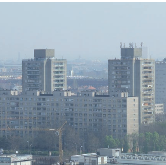
Panelház. A tartószerkezeteknek és válaszfalak szerkezeteinek is az állékonysága általában az előírt ideig fennmarad
