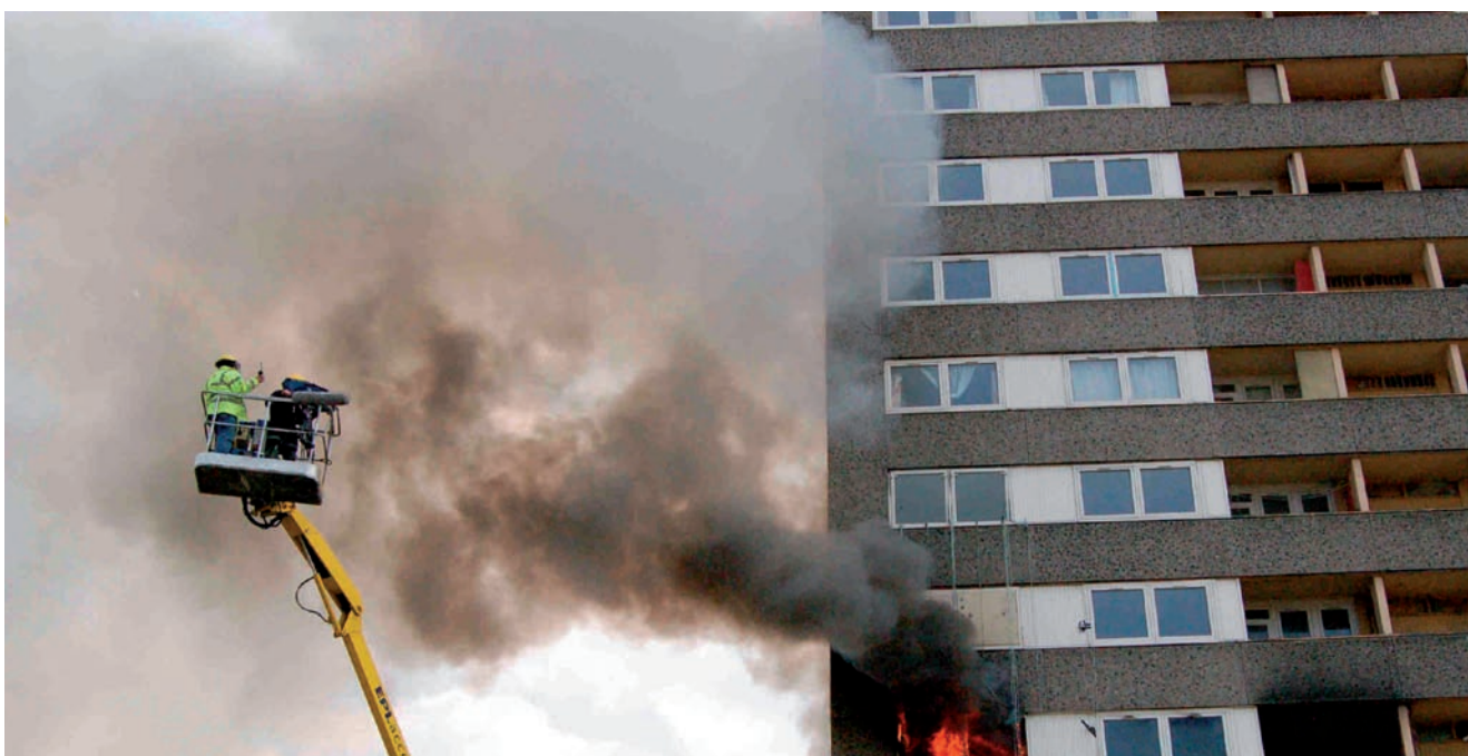
Paneltűz. Függetlenes homlokzati tűzterjedés útján is eljuthat az épületek egymás fölötti szintjeire
