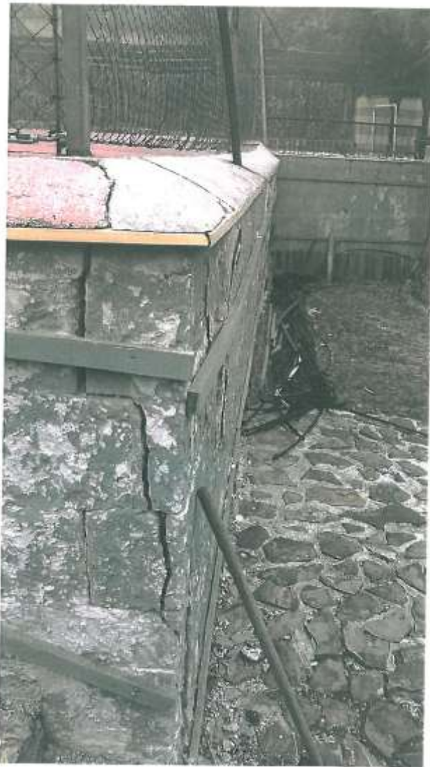
5. fénykép – 2 méteres támfal sarkának tönkremenetele
