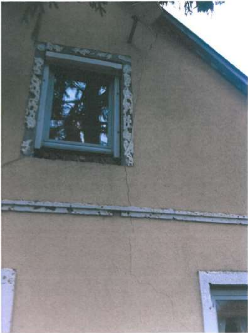
végigfutó repedés (É-Ny-i nommlokzat)
