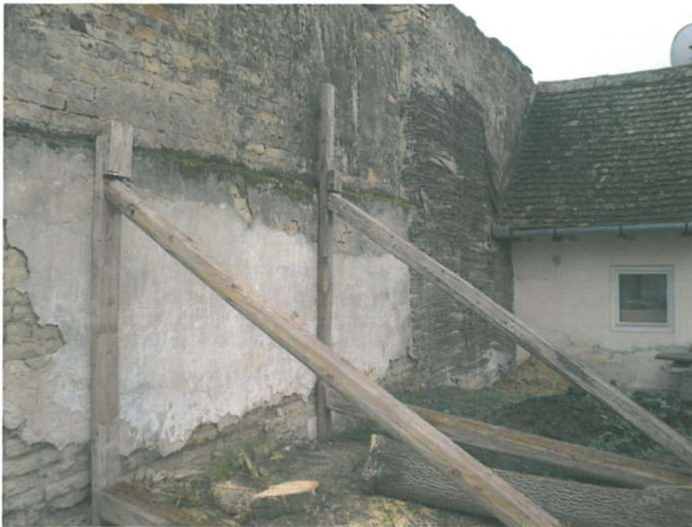
6. fénykép 1. sz. traktus falzatának dúcolása a szomszédos ingatlan felől
