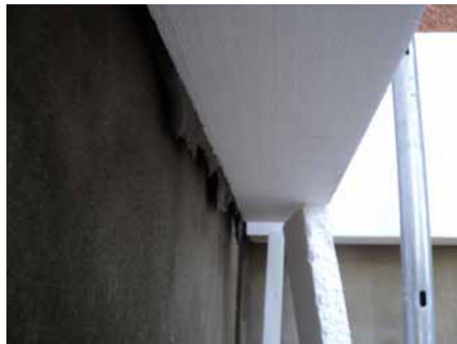
A rendszer hibás alsó lezárása, indítóprofil vagy ragasztórétegbe ágyazott hálókifordítás alkalmazása nélkül
