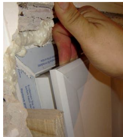
3. kép: Merevítés nélkül legyártott könnyen deformálódó PVC belső ajtó, felmérési méreteltérés miatt óriási illesztési réssel, félbemaradt beépítési folyamat után
