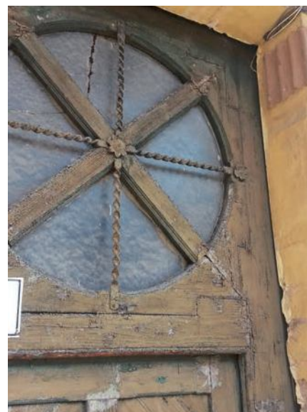
4. kép: Lógó szárny, akadozó nyitás, málló festés – amikor egy mives szerkezet karbantartása hosszú évekig elmarad
