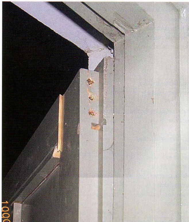
2. kép: Szakszerűtlen csapozásjavítás
