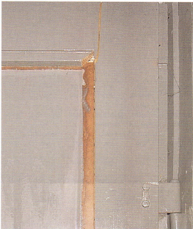
1. kép: Széthasadt garázsajtó sarok, hiányzó betétrögzítő lécs
