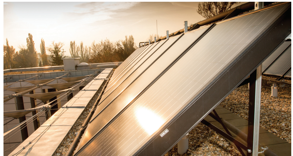
2. ábra: PV/T napelem modulok lapos tető szerkezetére erősítve
