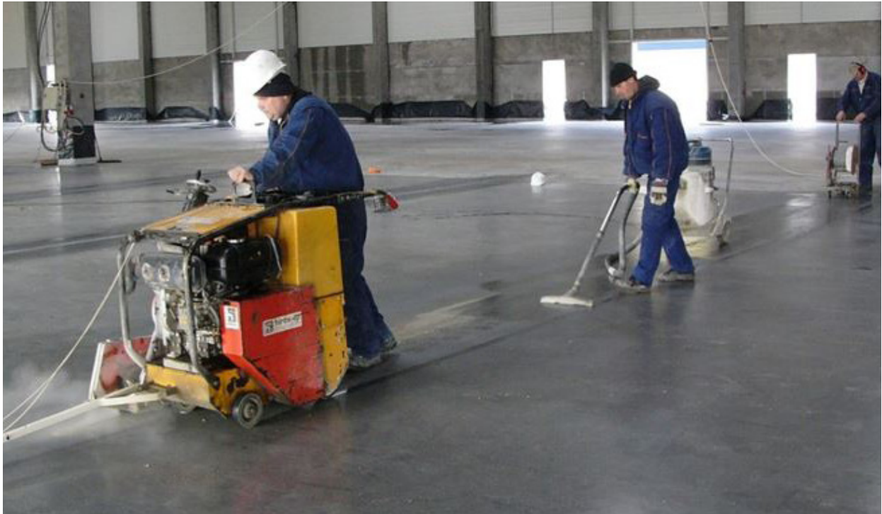
6.kép: fugavágás (forrás: Durostone Kft.)
