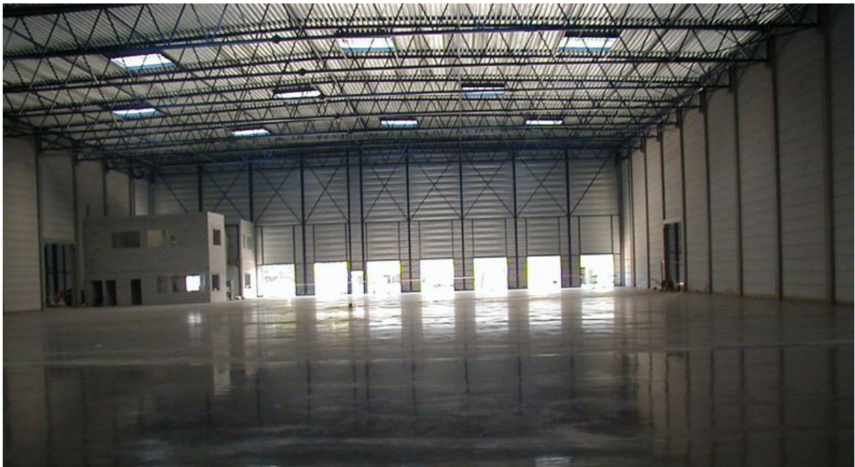
4.kép: nagytáblás, vágott-fugamentes ipari padló (forrás: Betonmix Kft.)
