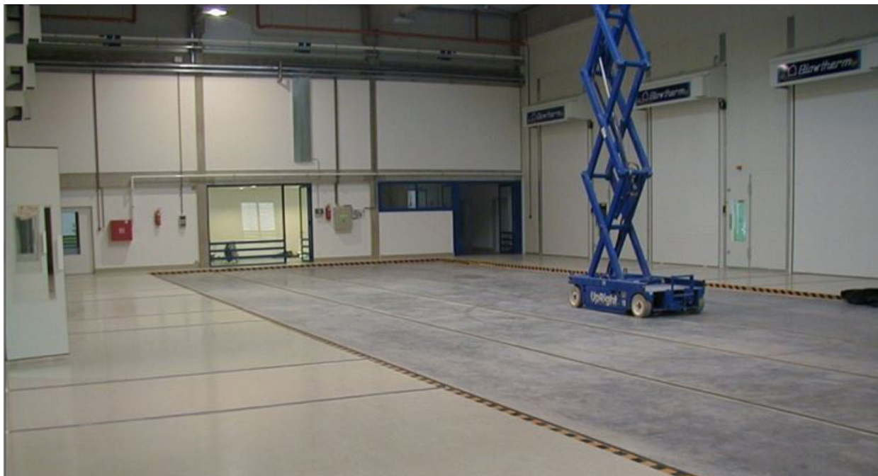
5.kép: műgyanta bevonatú és kéregerősített ipari padló (forrás: Betonmix Kft.)
