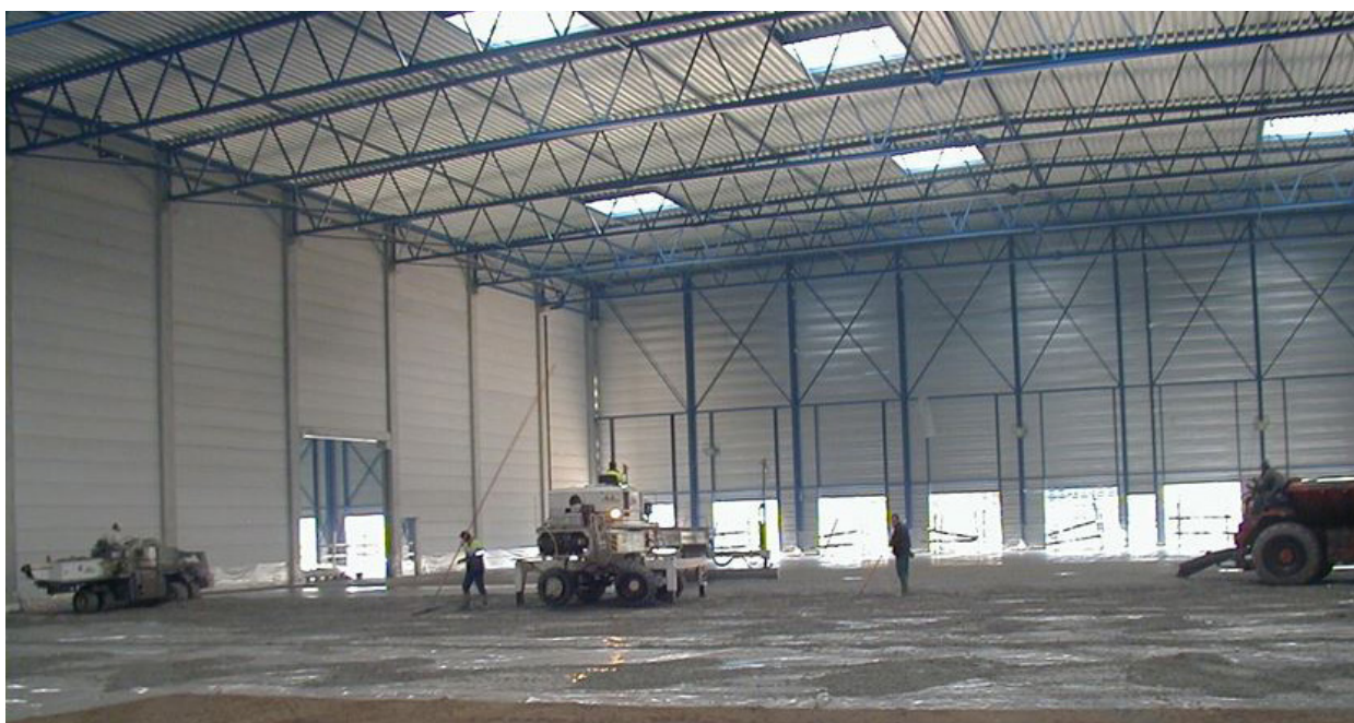
1 .kép: elkészült ágyazat fóliaterítéssel (forrás: Betonmix Kft.)
