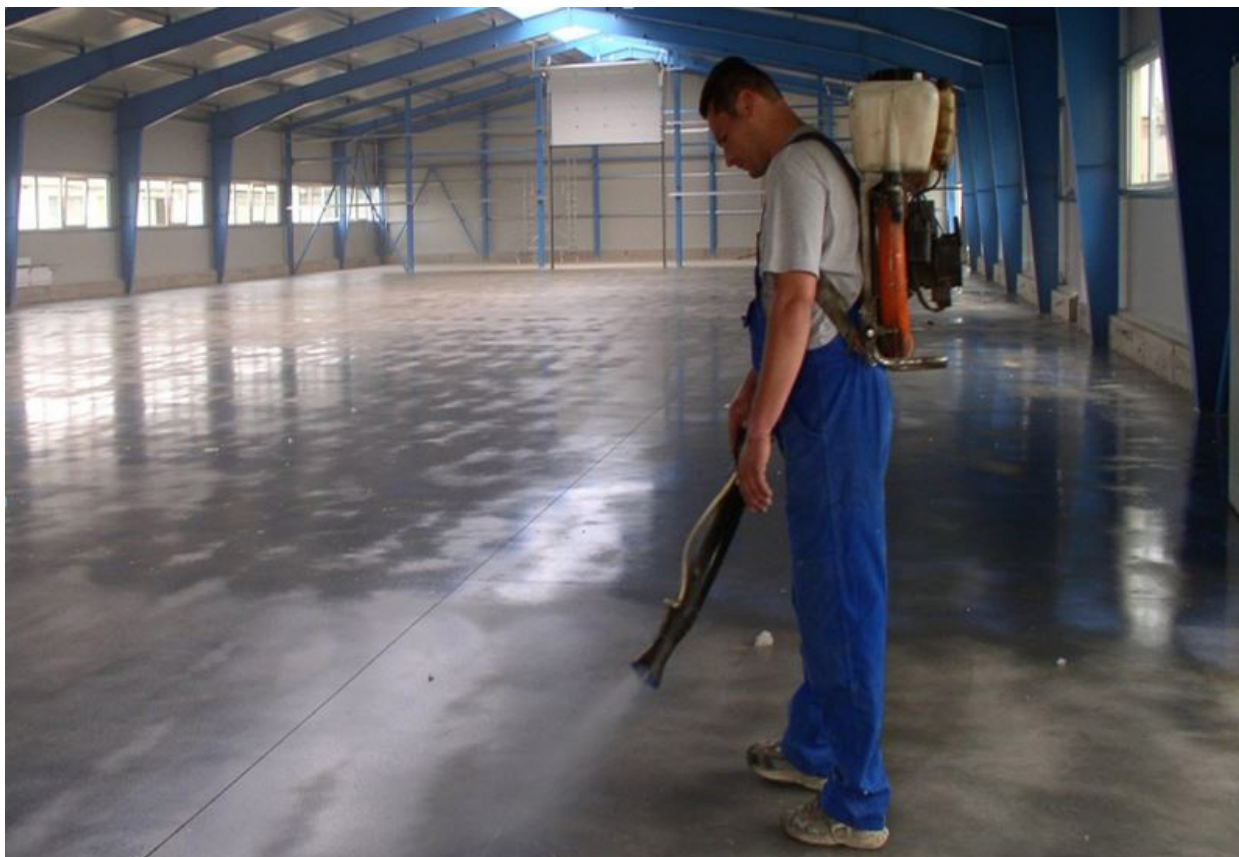
2.kép: Utókezelés párazáró permetezéssel. (forrás: Betonmix Kft.)
