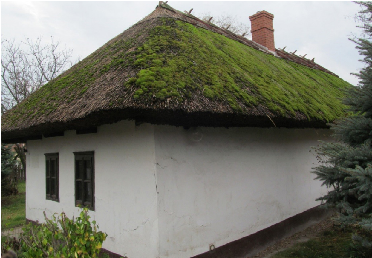
10. ábra: Mohával sűrűn benőtt nádtető (Forrás: http://www.indafoto.hu (letöltés dátuma: 2017.04.21.))
