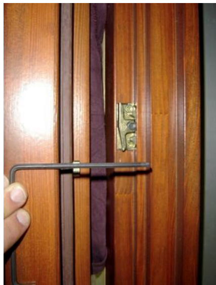
4. kép: A legjobb beállítás mellett sem működik a vasalat, ha rossz helyre csavarozzák a rögzítő elemet
