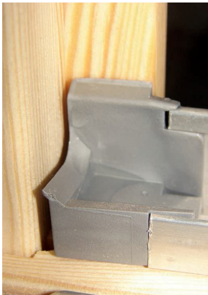
2. kép: A korszerű vízvezető rendszeralkatrészek is pontatlan összeépítés esetén beengedik az esővizet
