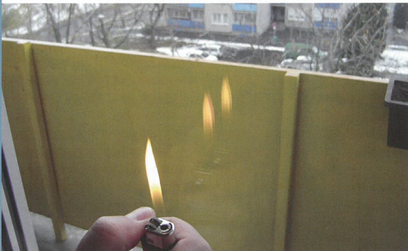
Az alacsony emissziós bevonat helyzetének, meglétének ellenőrzése „gyertyaláng-próbával”. A bevonat helyén a tükröződő kép színárnyalata eltérő. A belső üvegtáblán van a hővédő bevonat, a külsőn az esetleges napvédő bevonat
