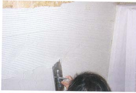
13. ábra: Képek a Masterclima szigetelő rendszer kivitelezéséről
