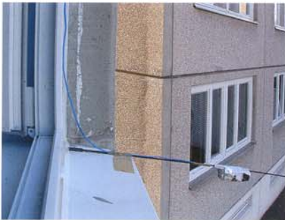
7. ábra: A külső léghőmérséklet-érzékelő elhelyezése
