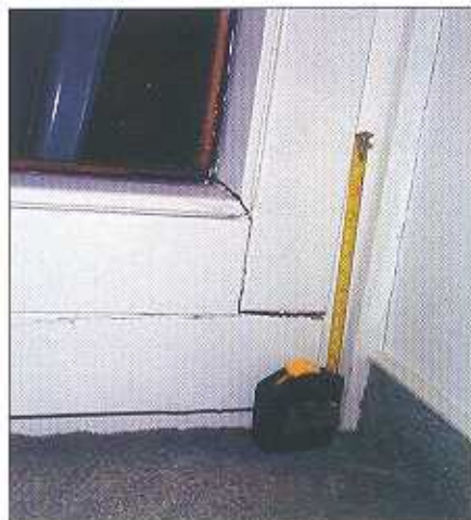
Párásodó, megdagadás miatt szétnyílt csapozású erkélyajtó alsó sarok.
