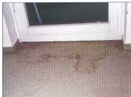
Pára megfolyás, beázás miatt átázott, foltosodó szőnyegpadló.
