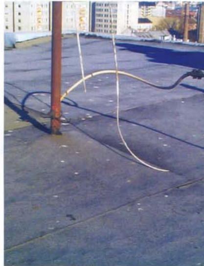
Gallérozás nélküli antennavezetés
