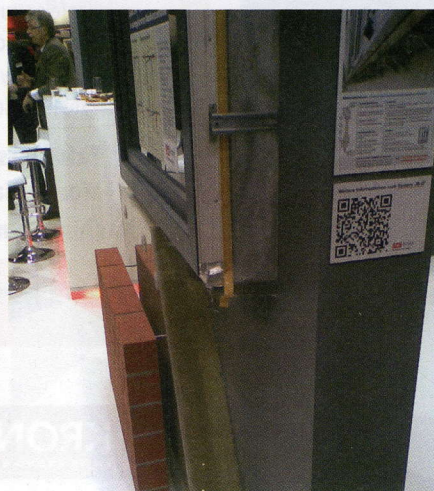
Konzolosan kinyúló ablakrögzítési megoldás csomópontja passzívház esetén
