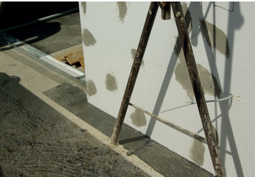
2. ábra: Lábazatképzésre alkalmatlan hőszigetelő anyag beépítése
