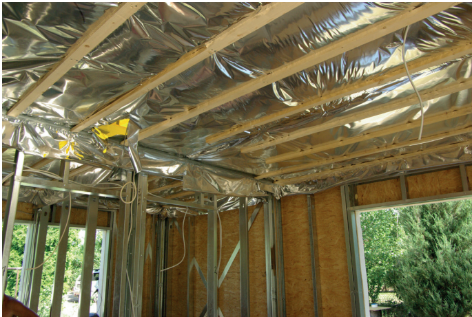
1.ábra: Szerelt épület kivitelezés közben
