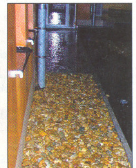
A tetőkertre érkező csapadékvíz lefolyása akadályozva volt, ezért a homlokzat mentén felduzzadt
