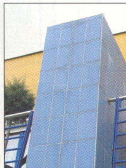
Kerámialap falburkolat, mely a fal átnedvesedését okozta
