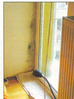
Páralecsapódás erkélyajtó üvegezésén. A kávéra nem fordították be a homlokzati hőszigetelést, ezért intenzív penészesedés alakult ki
